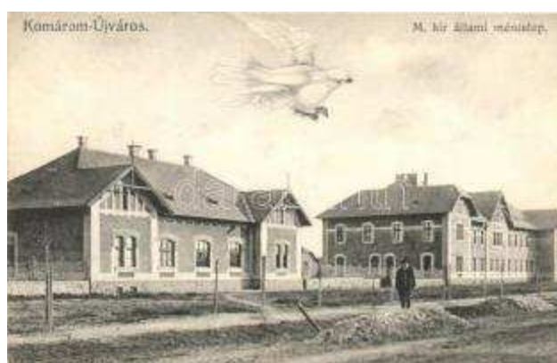
2. kép Főút felőli homlokzat a tisztai kaszinó épületével-korabeli foto
