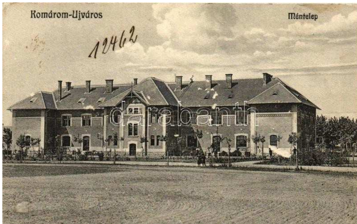
1. kép Főépület homlokzata a belső udvar felől – korabeli foto
