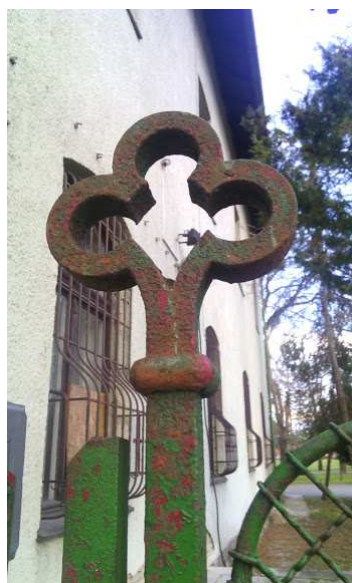
18-28. kép Épület és környezete
