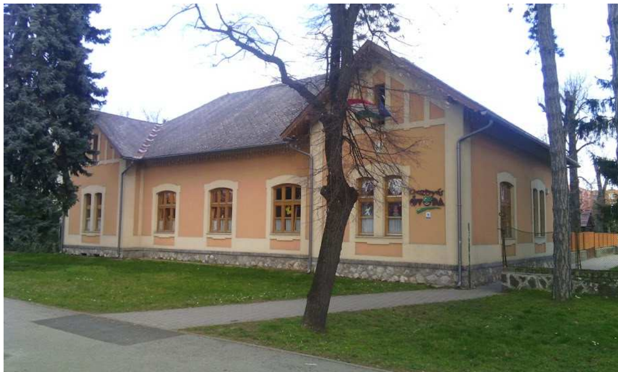
13. kép Óvoda főút felé eső homlokzata, volt altiszti kantine épülete
