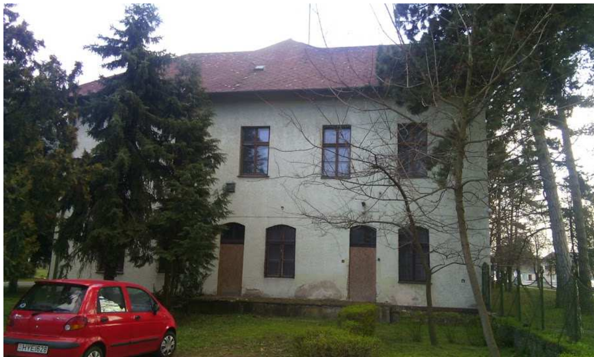
15. kép Átalakítandó épület északi homlokzata, volt kaszárnya épület
