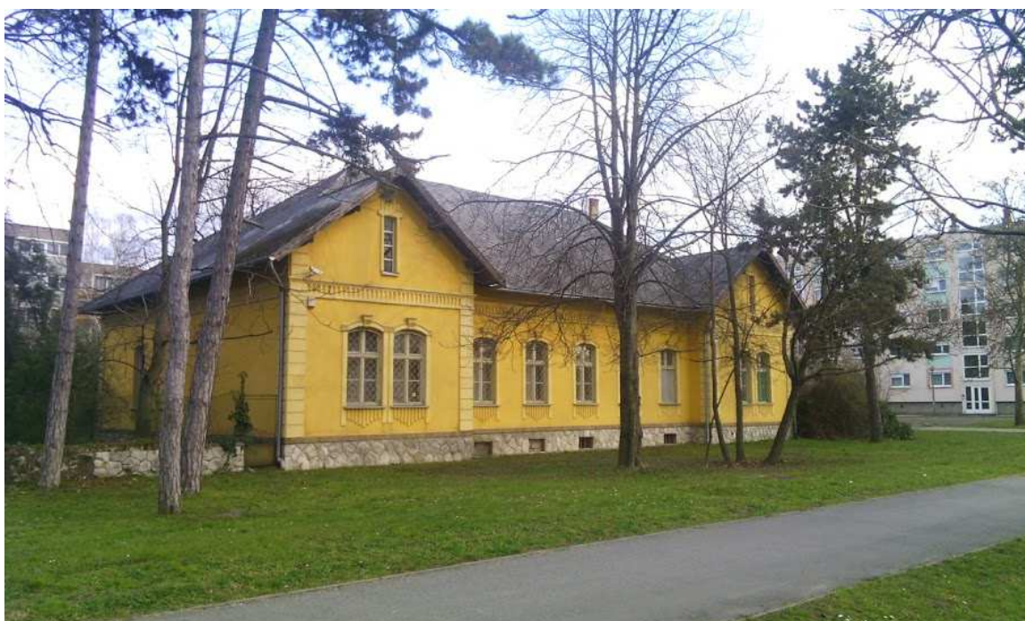
12. Lakóépület, volt parancsnoki épület
