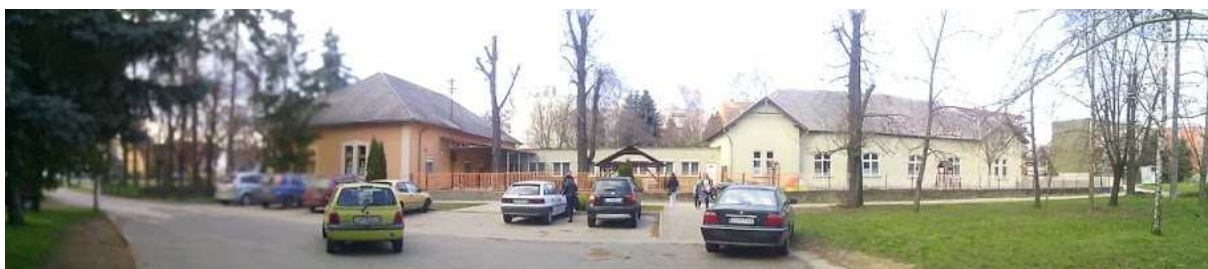
9. kép Óvoda belső homlokzat, volt altiszti kázinó épülete
