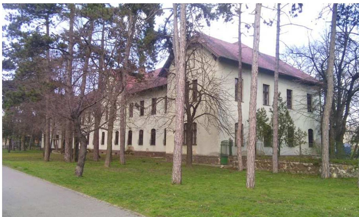
14. kép Átalakítandó épület főút felé eső homlokzata, volt kaszárnya épület
