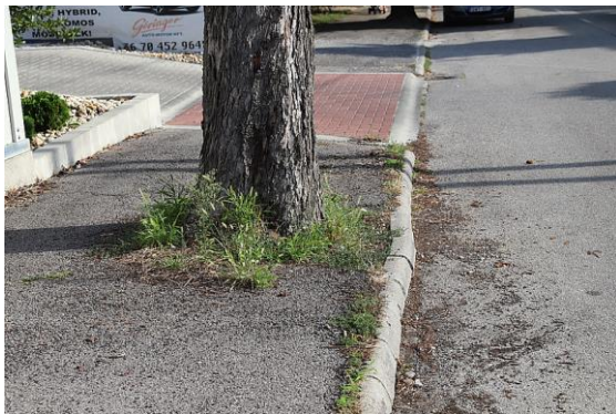
Védett vadgesztenye okozta károsodások az épített infrastruktúrában
